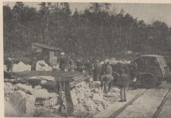
Okres „przedmiejski” — budowa przejazdu kolejowego łączącego zakład z powstającym osiedlem. Przy okazji znikła część baraków, w których mieszkali budowniczowie zakładu.
