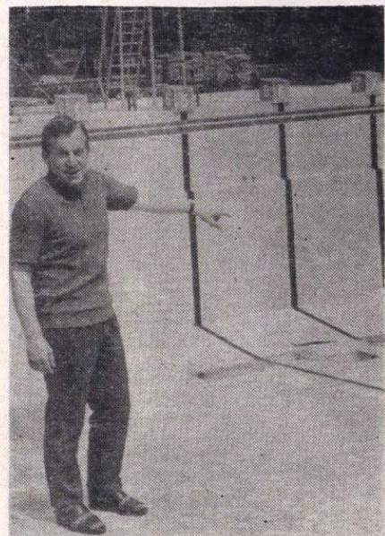
RAJMUND JOZWIŃSKI: W zimie w świdnickim basenie zapadły się płyty chodnikowe, którymi wykładano przez kilka lat dno odkrytej pływalni. Niektóre basenu wyłożyliśmy obecnie jasnym betonem. Tak więc przeszkodę usunięto z gwarancją na kilka lat.
