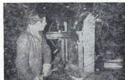
W wydziałach motocyklowych pracują ludzie o różnych zawodach. Są to tokarze, frezerzy, ślusarze i spawacze, których widzimy na zdjęciu, a którzy wykonują wiele operacji np. spawanie zbiorników na benzynę.
